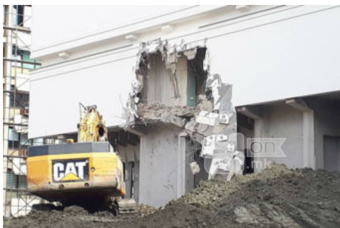
ВИДЕО: Се урива објектот на „ТЦЦ Плаза“ кај плоштадот ВМРО 6,665 views
